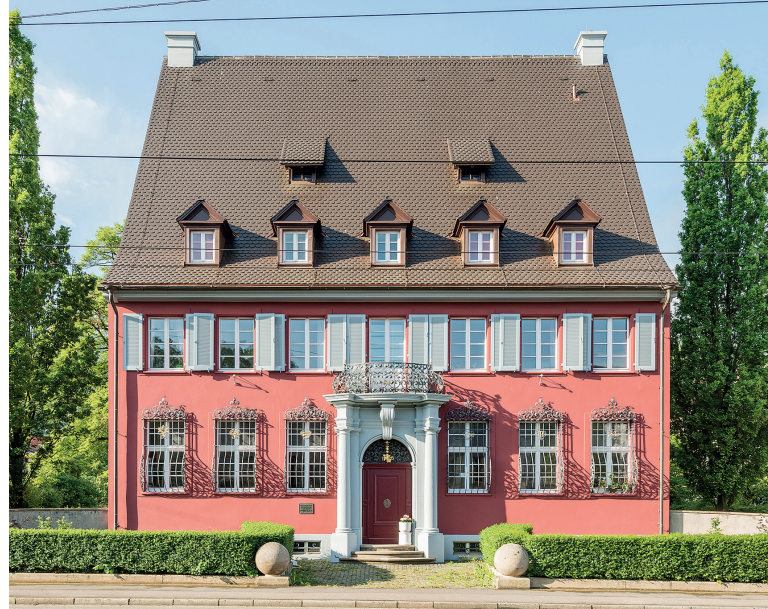
Das Gebäude des Vereins „Badische Heimat“ nach der Sanierung von Dach, Fassade und Dachgeschoss
