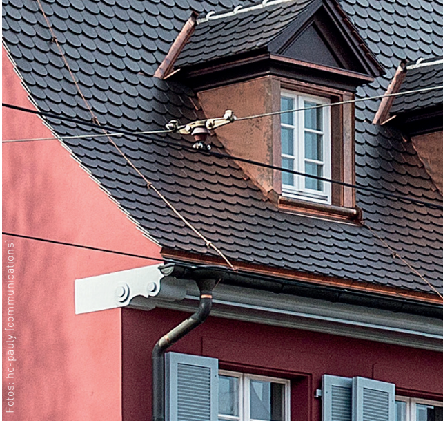
Detail des Gebäudes mit Dachanschluss und Gesims
