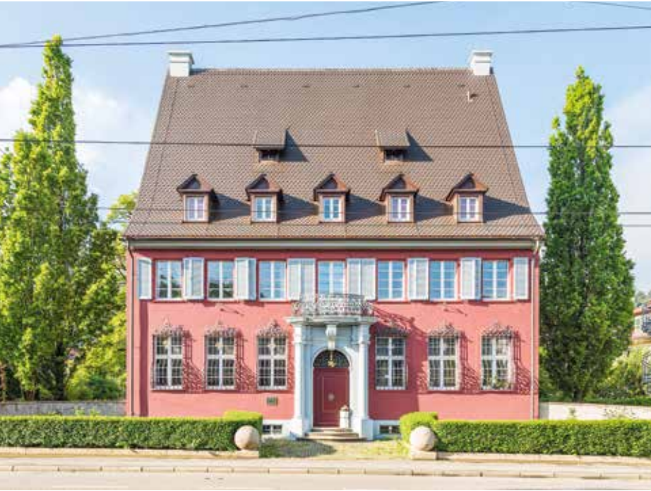
Abb. 1: Das Gebäude des Vereins „Badische Heimat“ nach der Sanierung von Dach, Fassade und Dachgeschoss
