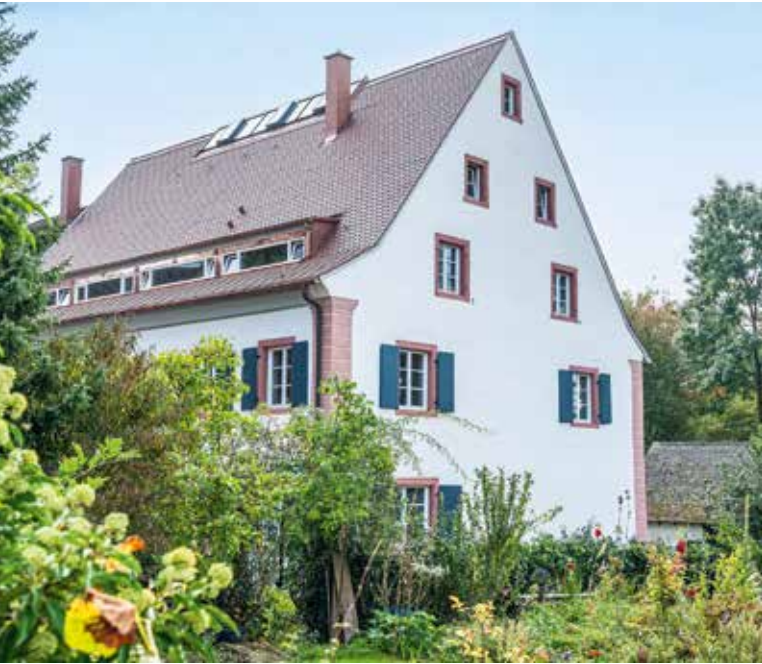
Abb. 3: Das denkmalgeschützte Mühlengebäude nach der energetischen Sanierung und dem Gebäudeumbau
