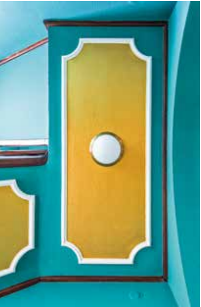
Detailausschnitt mit der Deckenunterseite des Treppenpodestes
