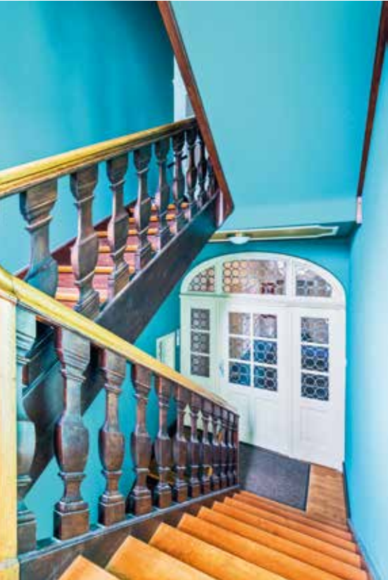
Bei der Sanierung des Treppenhauses wurden die bauzeittypischen Farben der Zeit des Expressionismus wiederhergestellt.
